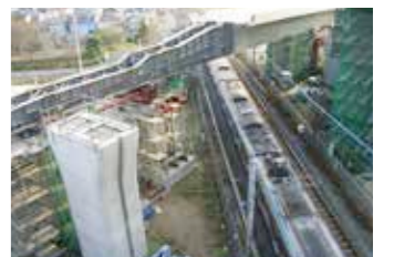
押し出し架設工法
