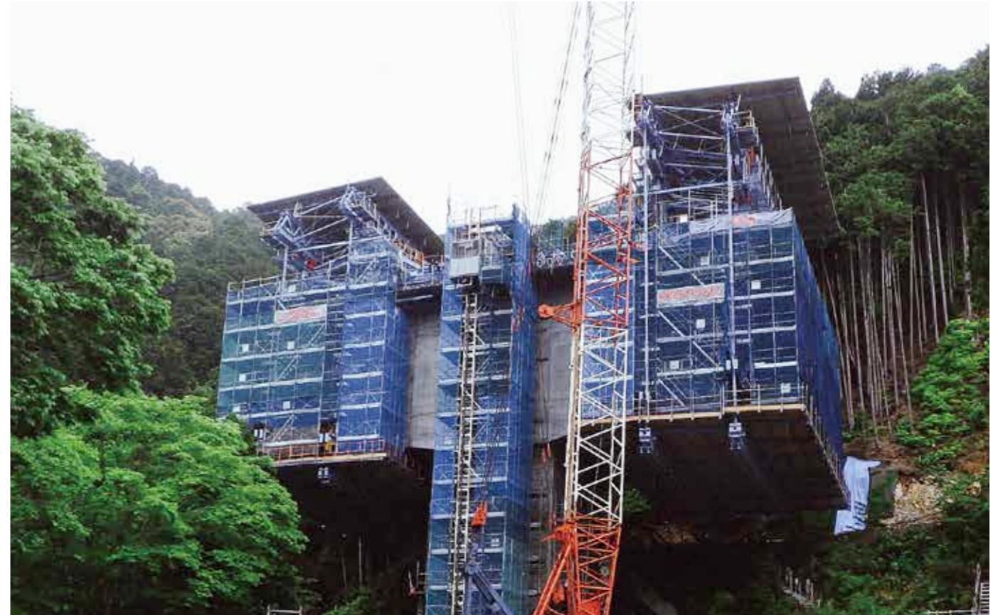
片持架設工法
