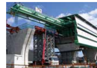
大型移動支保工架設工法
