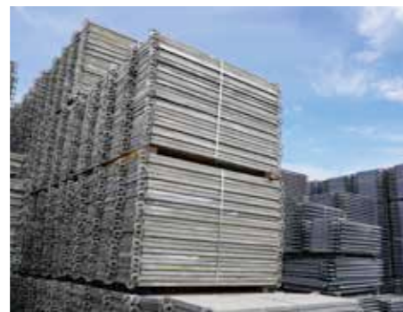
整備完成布板材ヤード
